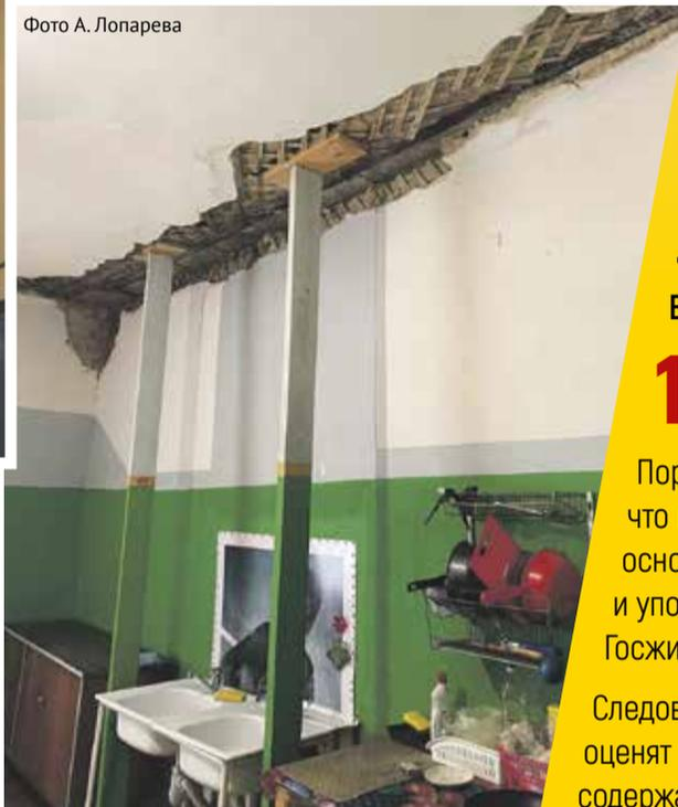
Двухэтажный дом на улице Кудрявцева на грани обрушения. Потолки на подпорках, стены в трещинах, с фасада падают кирпичи, искрит неизолированная проводка. Но дом все еще обитаем, здесь живут люди!
